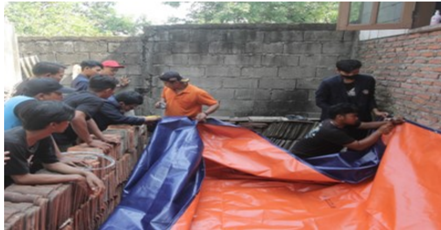
Gambar 4. Pemasangan terpal untuk pembuatan kolam 1
