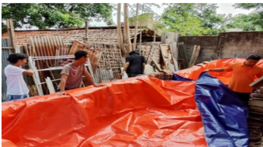
Gambar 6. Pemasangan terpal untuk pembuatan kolam 2
