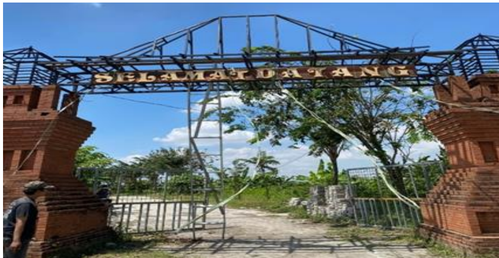
Gambar 7. Pemasangan plang bertuliskan “Selamat Datang”
